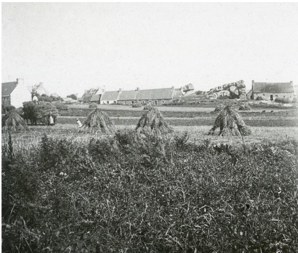
KEREDOL vers 1900 : Les rochers de Creac'h Lousset permettent de situer la photo
